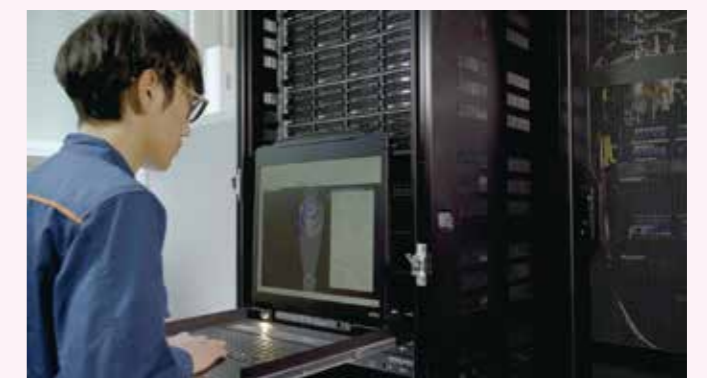
スーパーコンピューター Supercomputers
