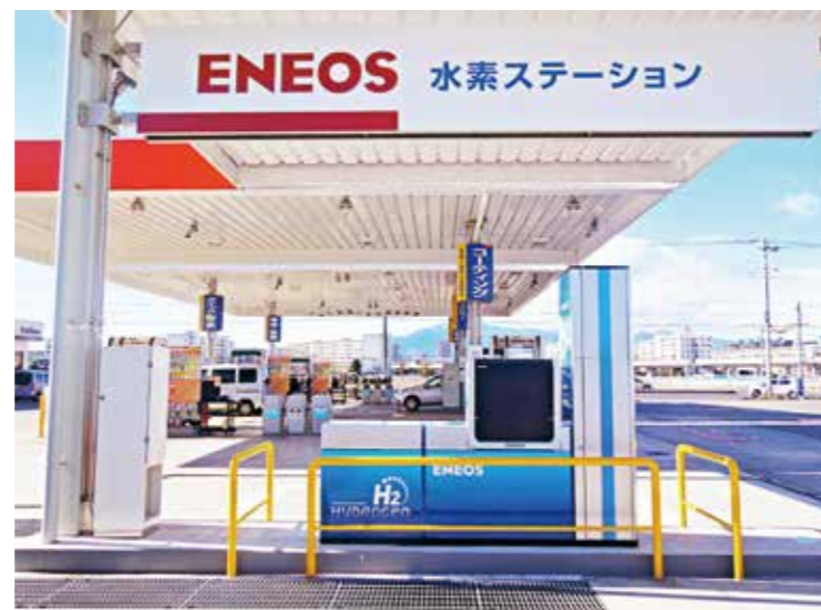
水素ステーション Hydrogen Refueling Station
